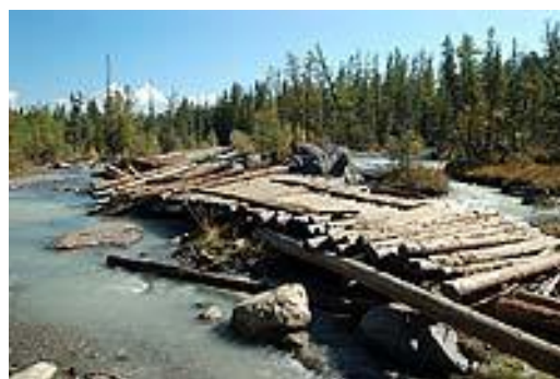
Фото 21. Мост через р. Актру
