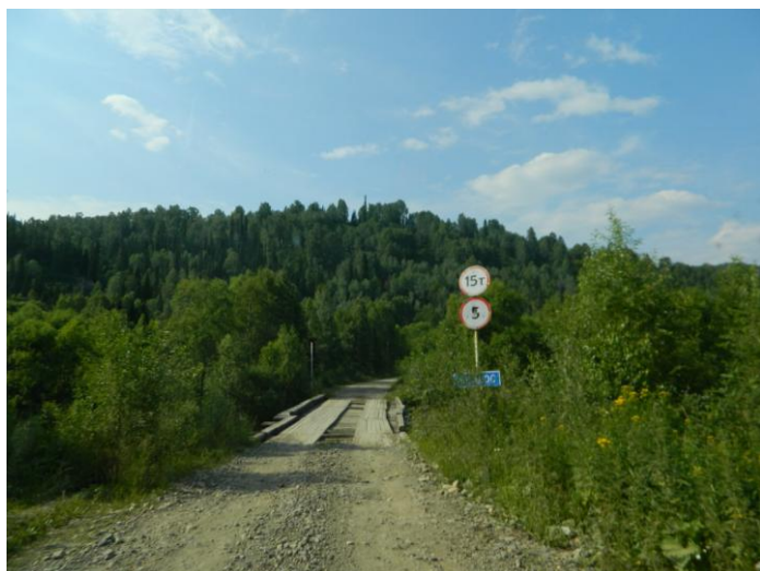
Фото 191. Мост через р. Колос
