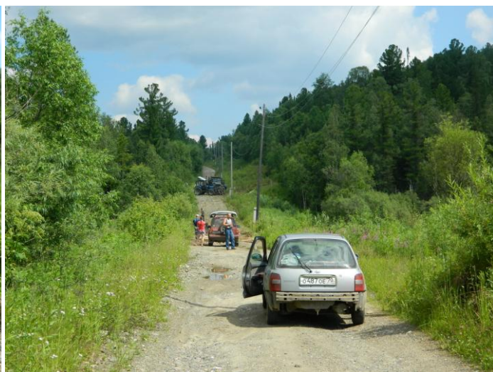
Фото 36. Ремонтные работы на промоине
