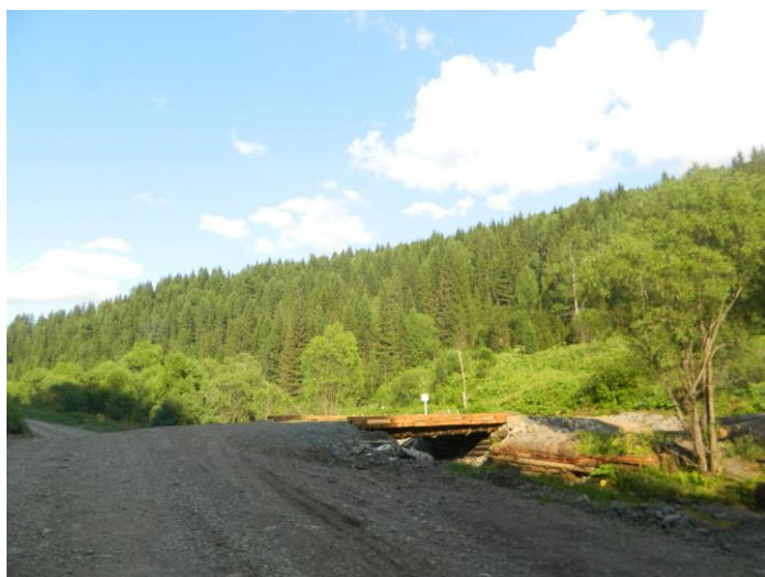
Фото 45. Мост перед поселком Новый Берикуль
