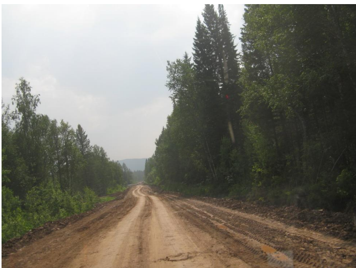
Фото 78. Ремонт дороги на Приисковый
