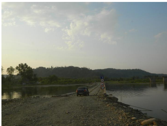
Фото 203. Понтонный мост через р. Томь в Майзасе
