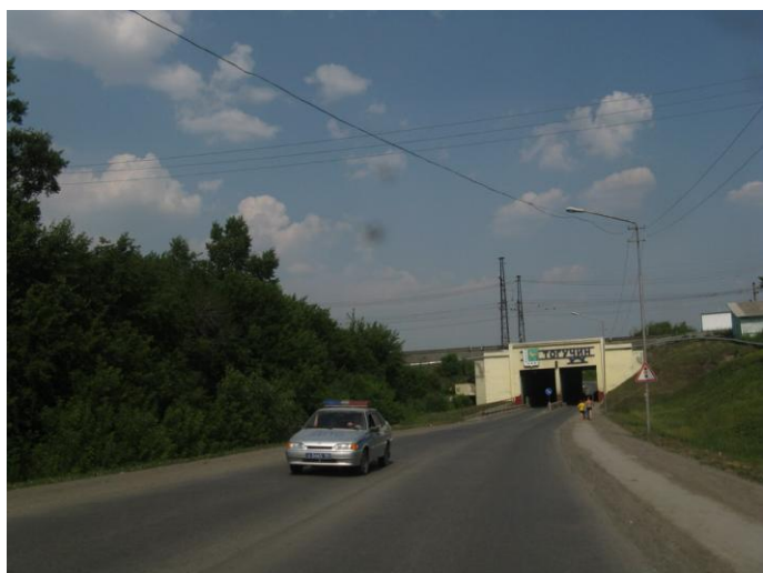
Фото 213. Перед тоннелем в Тогучине
