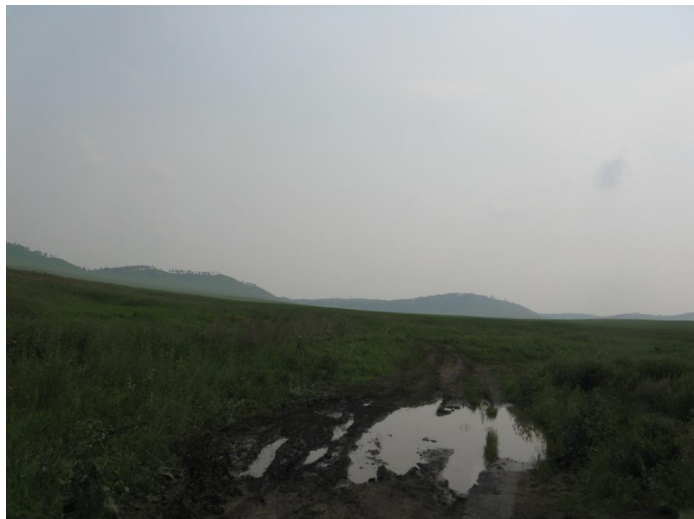
Фото 67. Разбитая грунтовка на восток
