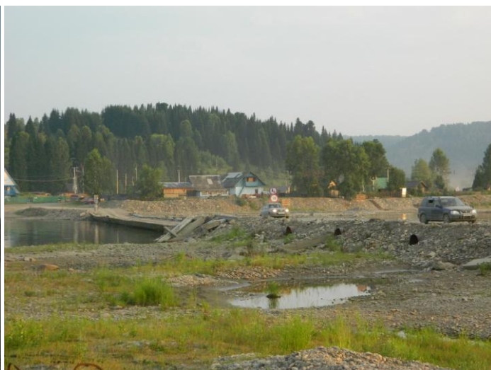
Фото 204. Понтонный мост через р. Томь в Майзасе
