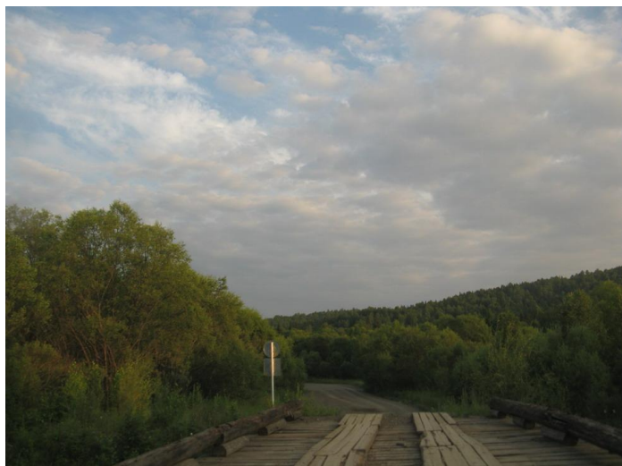
Фото 53. Мост через р. Кургускуюлка
