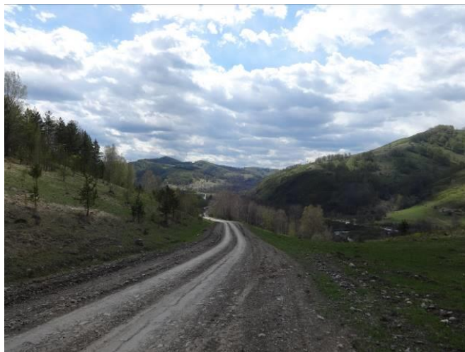
Фото 41. Участок гравийной дороги
