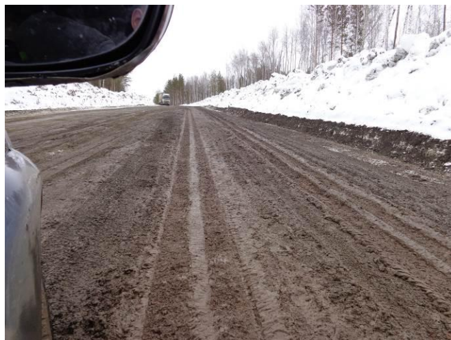
Фото 8. Грунтовка после п. Нижний Ингаш
