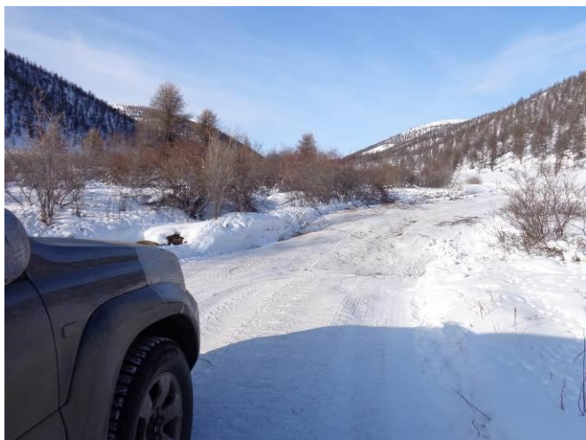
Фото 95. Ямы на дороге
