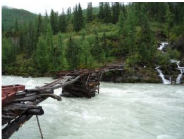
Фото 134. «Мост» через р. Чуя
