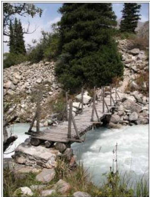
Фото 261. Мост через реку
