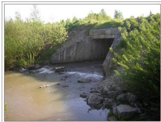
Фото 6. Мост через р. Каменку (утром)
