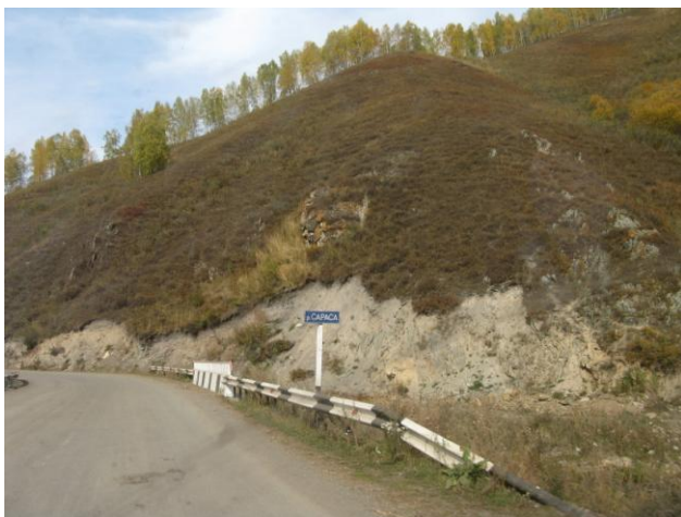
Фото 39. Мост через реку Сараса
