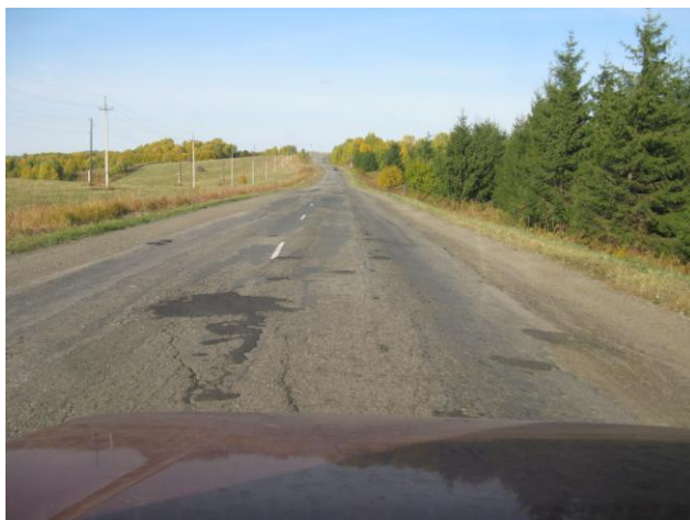
Фото 7. Дорога через Салаирский кряж
