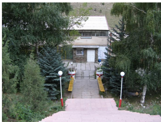
Фото 178. Вход в водолечебницу
