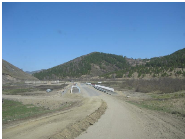
Фото 22. Мост через р. Баранча
