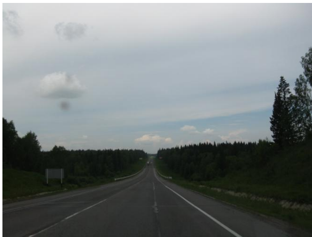
Фото 160. Федеральная трасса М53
