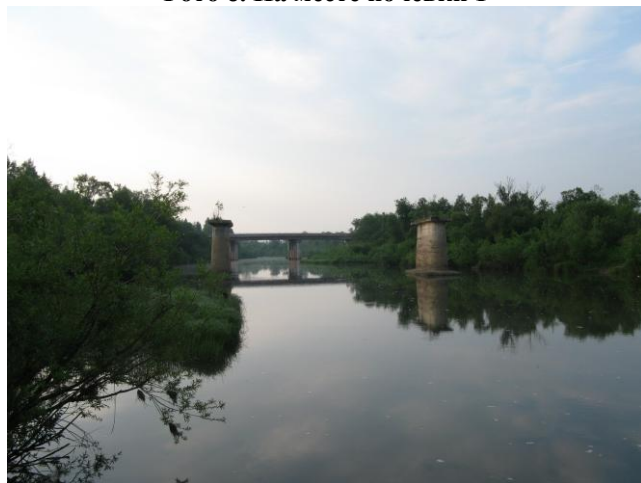
Фото 8. Старые опоры и новый мост через Золотой Китат
