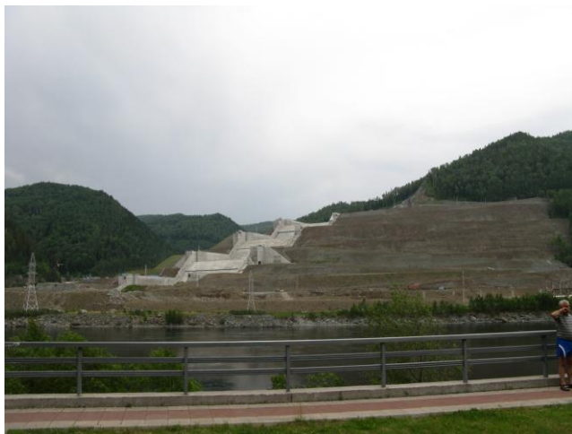
Фото 123. Береговой водосброс СШ ГЭС
