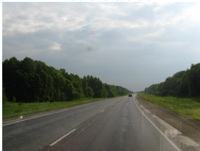
Фото 12. Федеральная трасса М53
