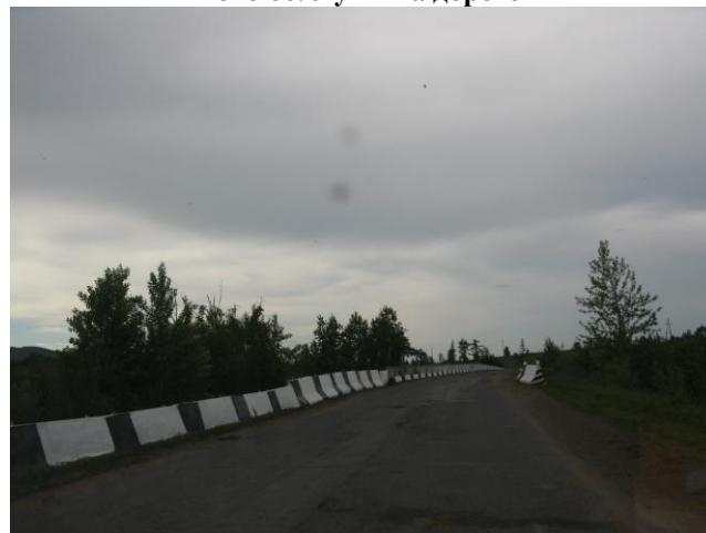
Фото 68. Мост через Белый Июс
