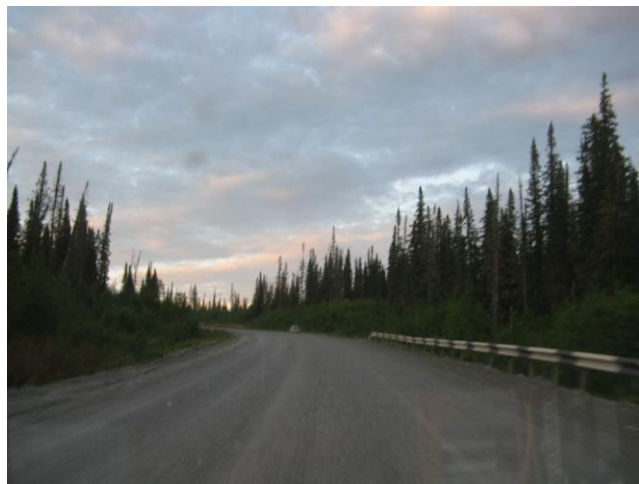
Фото 144. На перевал в районе Крольского тоннеля
