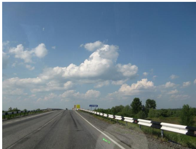
Фото 169. Мост через Чулым за Ачинском
