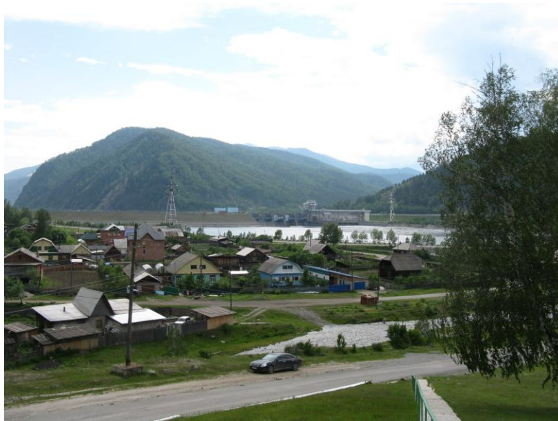
Фото 130. Плотина Майнской ГЭС
