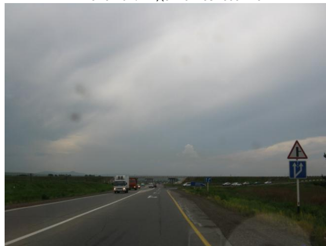
Фото 163. Развязка на объездной дороге
