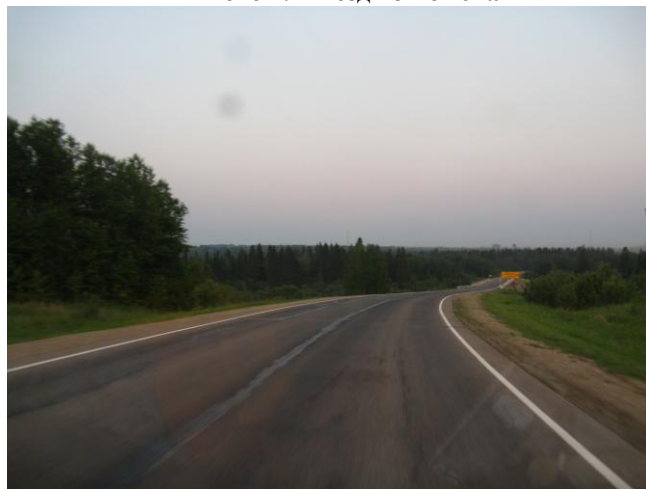
Фото 4. Перед мостом через р. Яя
