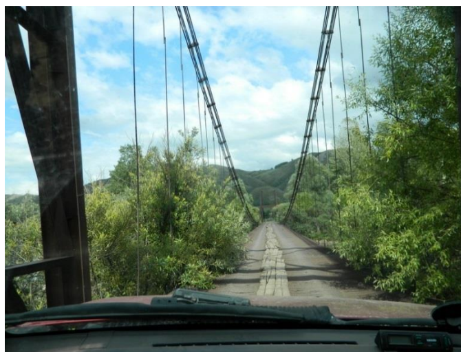
Фото 66. Мост через р. Иня
