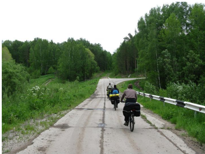
Фото 7. Плиты в конце дороги
