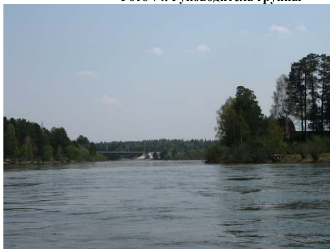
Фото 76. Устье р. Лебедь и мост
