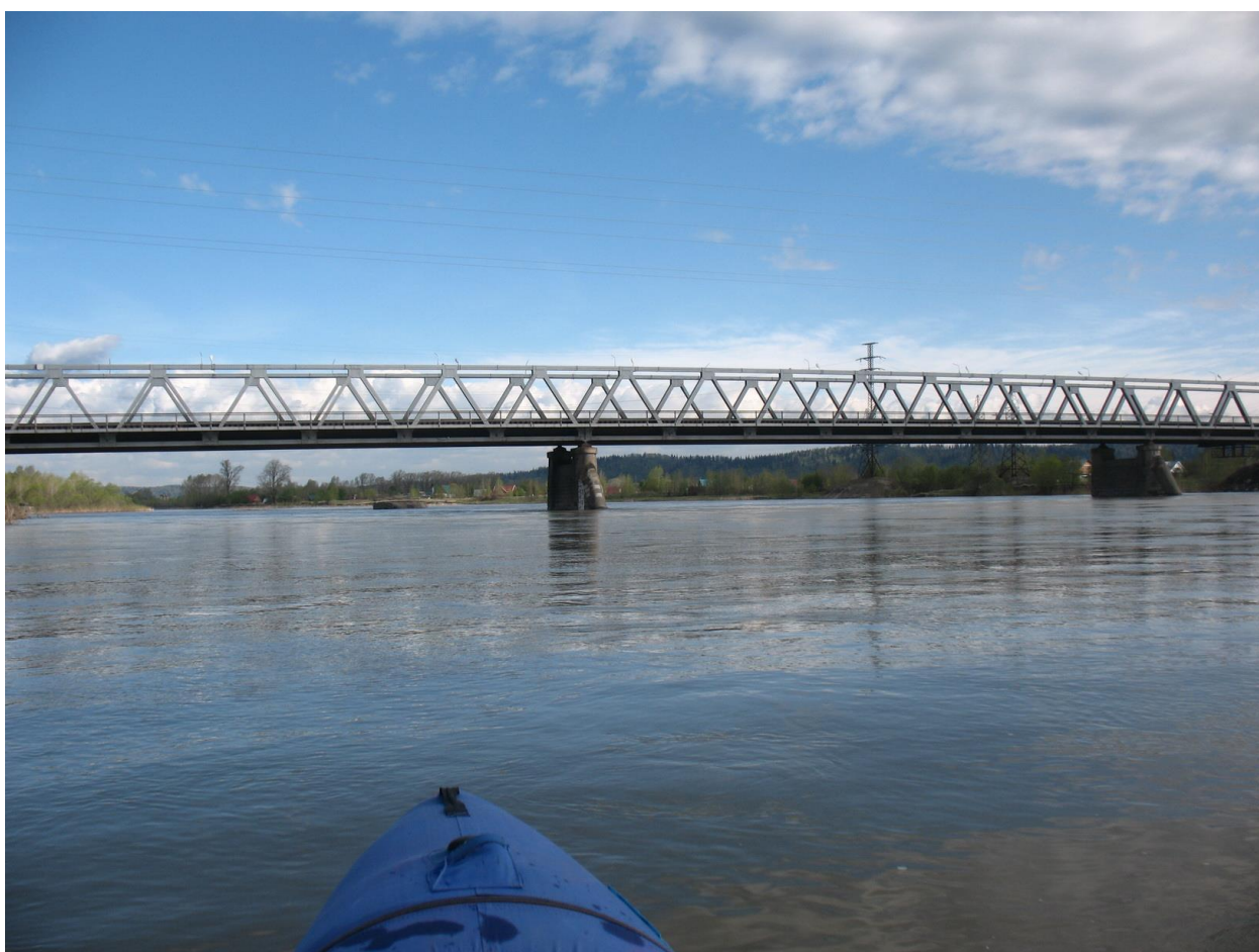
Фото 66. Перед автомобильным мостом на трассе Новокузнецк-Междуреченск
