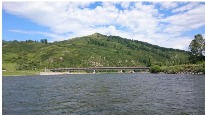
Фото 76. Мост через Чарыш по трассе Сентелек-Аба
