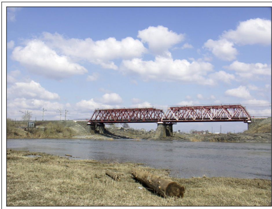
Фото 34. Железнодорожный мост через р. Яя
