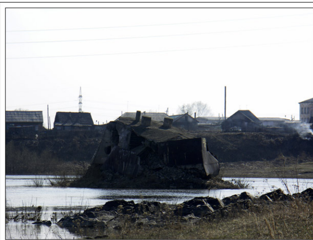
Фото 33. Ледолом на р. Яя возле ж-д. моста
