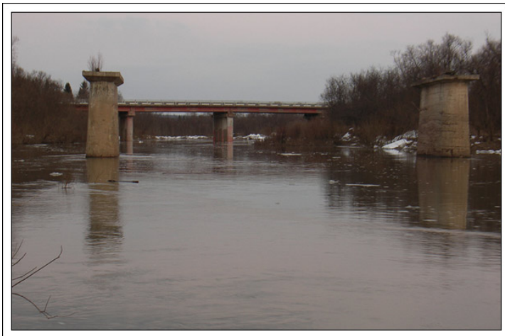
Фото 3. Новый мост и опоры старого
