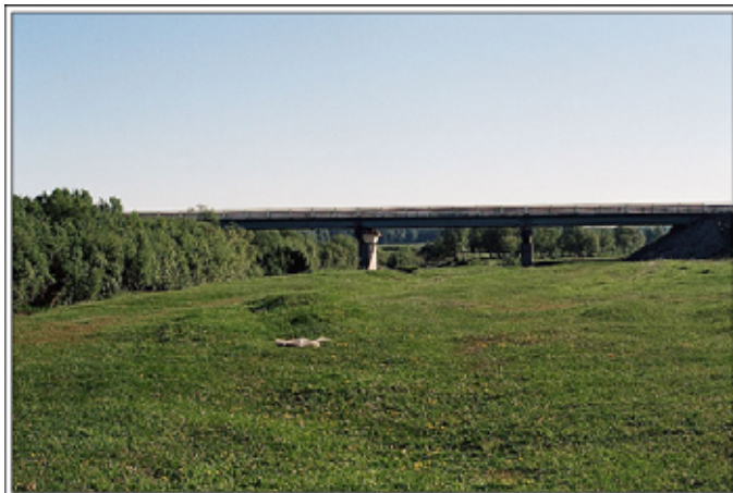
Фото 10. Мост через р. Лебяжья
