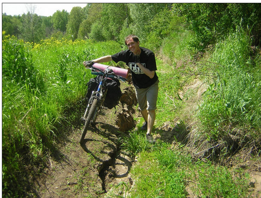
Фото 82. Промойны на дороге
