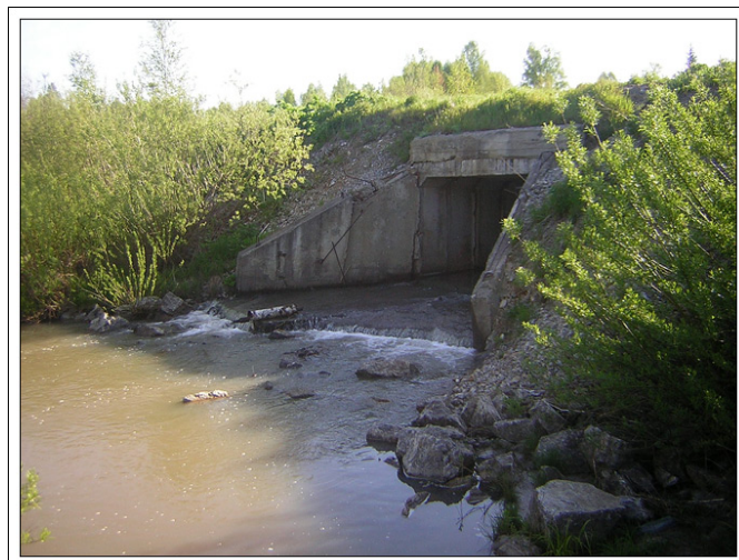
Фото 6. Мост через р. Каменку (утром)
